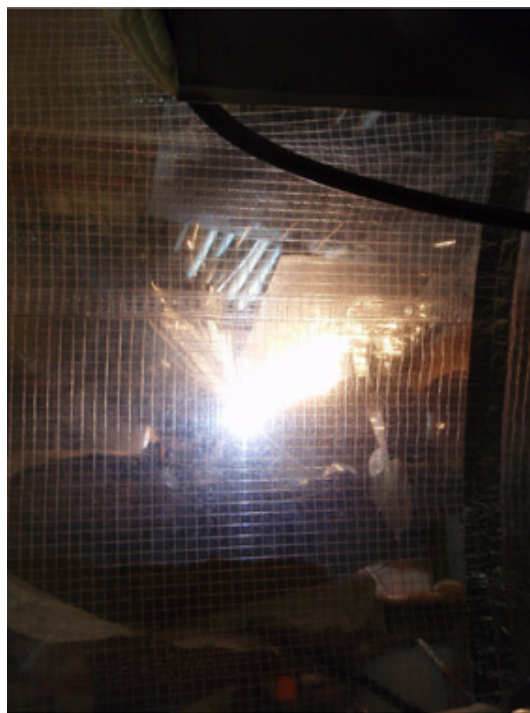
図 3.4.2-8 焼却炉の排気冷却器(熱交換部)のブロマゾム溶解断作業
