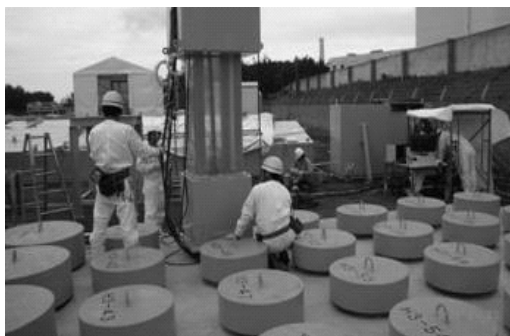
保管体吊上げ作業
