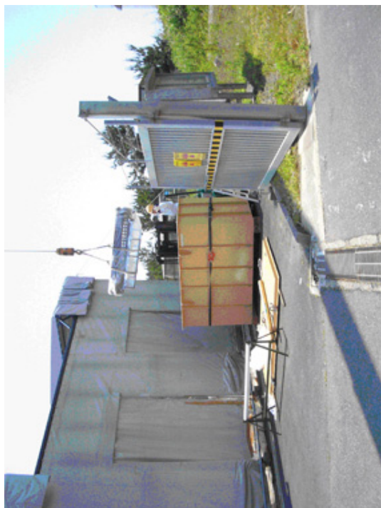
図 3.4.2-1 保管廃棄施設から取出した大型廃棄物を運搬容器に収納
